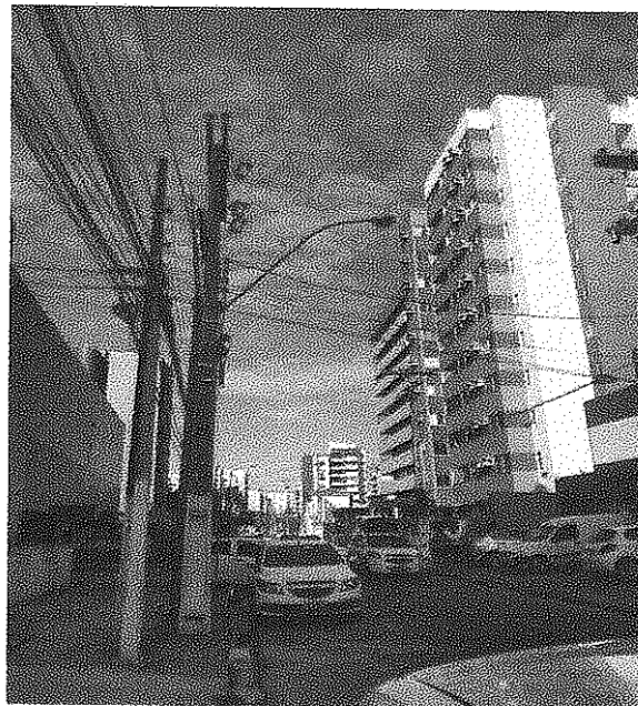
Imagem 8 - Luminárias fora do padrão na Avenida Durval Guimarães Fonte: Própria/Amostra
