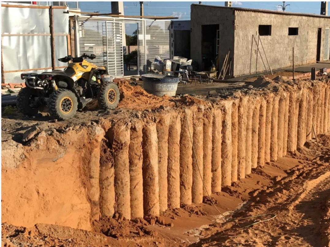
**Figura 41 – Exemplos de execução para contenção em DSM.**
