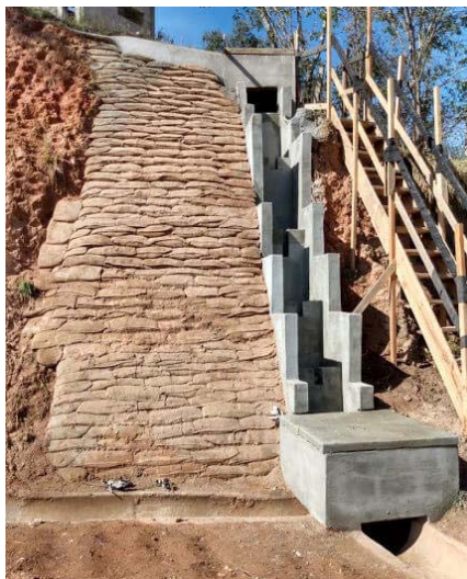
Figura 6: Exemplo de rip-rap ensacado para recompor área escavada para a escada.
