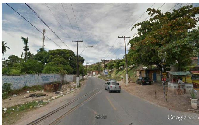
Figura 60 – Av. Major Cícero de Góes Monteiro x Av. Francisco de Menezes x R. Gen. Hermes – ausência de tratamento para circulação de pedestres
