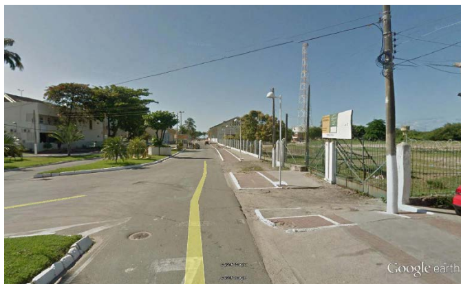
Figura 97 – Av. Maceió (Ciclovía da Orla Litorânea) – Irregularidades e descontinuidade em trecho na Zona Portuária
