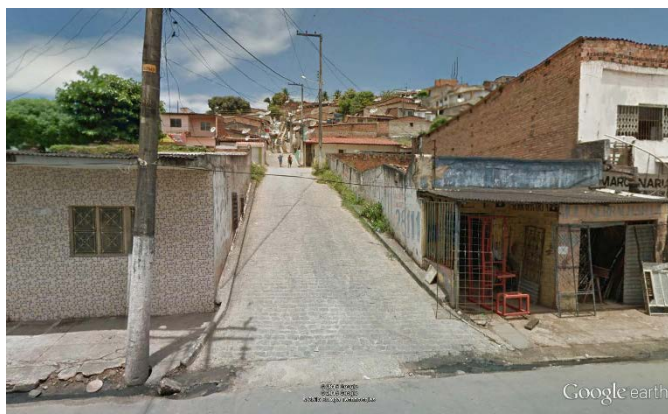
Figura 74 – Av. Maj. Cícero de Góes Monteiro x Travessa Antônio – Ausência de calçada, piso irregular na calçada da avenida
