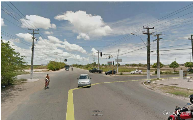
Figura 82 – Av. Cachoeiro do Meirim x Av. Benedito Bentes (bairro Benedito Bentes) – interseção sem calçada, sem faixas de travessia e ilhas físicas de proteção (“refúgios”)
