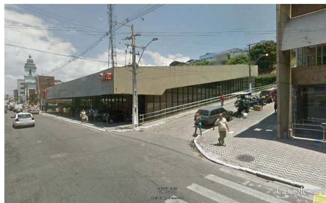
Figura 26 – Av. do Imperador – Ladeira Boa Vista
