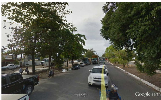
Figura 62 – BR-104 – proximidades da rotatória da Polícia Rodoviária Federal, pista sentido Aeroporto – trechos sem calçada e passeios
