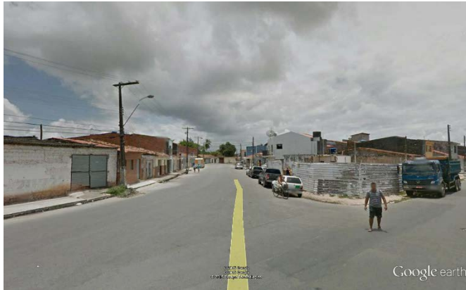
Figura 78 – Av. Monte Castelo x Travessas Monte Castelo (bairro Vergel do Lago) – calçadas estreitas, grandes áreas de interseção de vias sem faixas de travessia e ilhas físicas de proteção na travessia do leito viário (“refúgios”)
