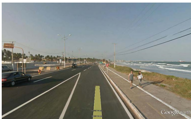
Figura 93 – Av. Assis Chateaubriand após Ponte Divaldo Suruagy (Ciclovia da Orla Litorânea) – Falta de sinalização e obstáculo na ciclovia
