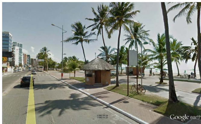
Figura 98 – Av. Dr. Antônio Gouveia (Ciclovía da Orla Litorânea) – Ausência de locais para guarda de bicicletas (bicicletários e paraciclos) ao longo da ciclovía
