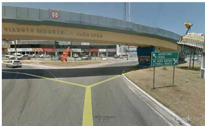
Figura 47 – Avenida Dona Constança, no acesso à Avenida Almirante Álvaro Calheiros
