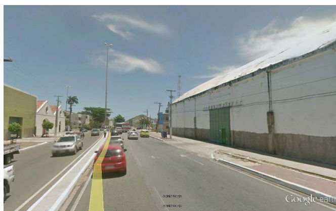
Figura 96 – Av. Maceió (Ciclovia da Orla Litorânea) – Irregularidades no piso da ciclovia e falta de continuidade (sinalização horizontal) nas travessias
