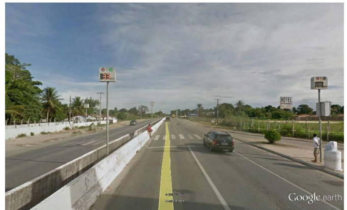
Figura 83 – BR-104 em Rio Largo – travessia semaforizada de pedestres na rodovia – sinalização horizontal apagada
