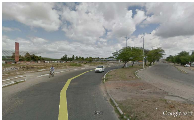
Figura 87 – Av. Senador Rui Palmeira (Ciclovía Lagunar) – Resquícios da ciclovía nos dois lados da via
