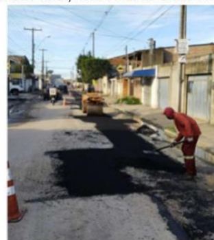
Aplicação de CBUQ para “tapa-buracos”. Fonte: Diário de obras, Acervo interno Uchôa Construções
