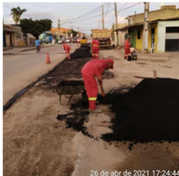
Aplicação de CBUQ para "tapa-buracos". Fonte: Diário de obras, Acervo interno Uchôa Construções
