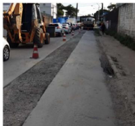
Execução de corte para alinhamento, preparo de base recomposta Fonte: Diário de obras, Acervo interno Uchôa Construções
