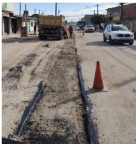
Execução de pintura de ligação, para aplicação de CBUQ. Fonte: Diário de obras, Acervo interno Uchôa Construções
