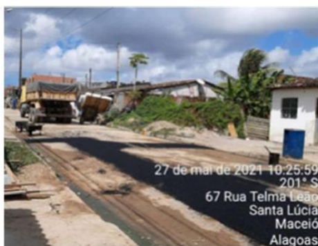
Recomposição de rua, com “tapa-buracos” executado. Fonte: Diário de obras, Acervo interno Uchôa Construções
