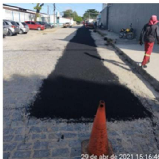
Trecho após execução de "tapa-buracos". Fonte: Diário de obras, Acervo interno Uchôa Construções
