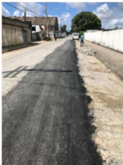
Trecho após execução de "tapa-buracos". Fonte: Diário de obras, Acervo interno Uchôa Construções
