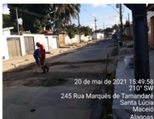
Reparo de base de pavimentação, preparação para imprimação. Fonte: Diário de obras, Acervo interno Uchôa Construções
