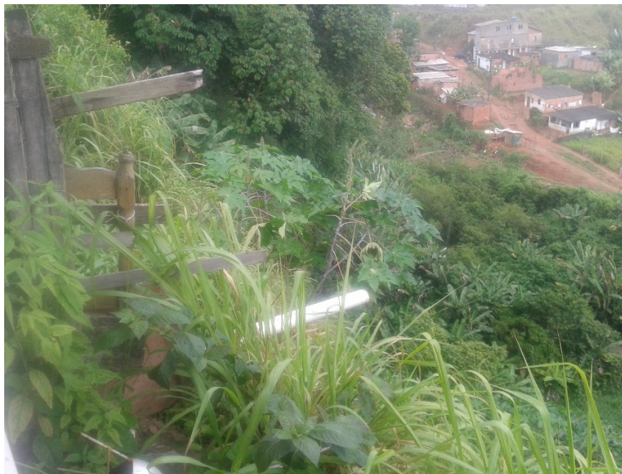
Esgoto sendo despejado diretamente sobre o talude.
