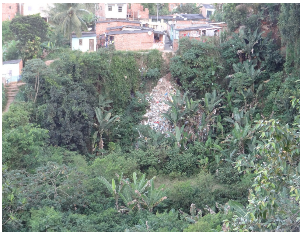
Figura 5.4 – Grande quantidade de lixo/entulho lançado sobre a face da pedreira
