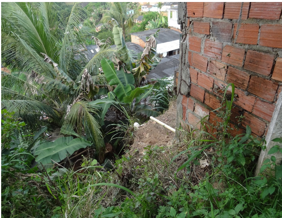
Figura 5.5 – Lançamento de água/esgoto e proximidade da crista do talude com a edificação
