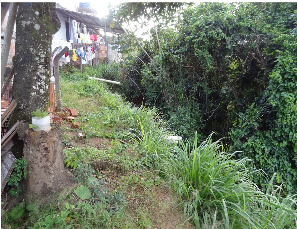
Figura 5.6 – Edificações próximas à crista do talude, lançamento de água/esgoto e árvore de grande porte da proximidade da face do talude
