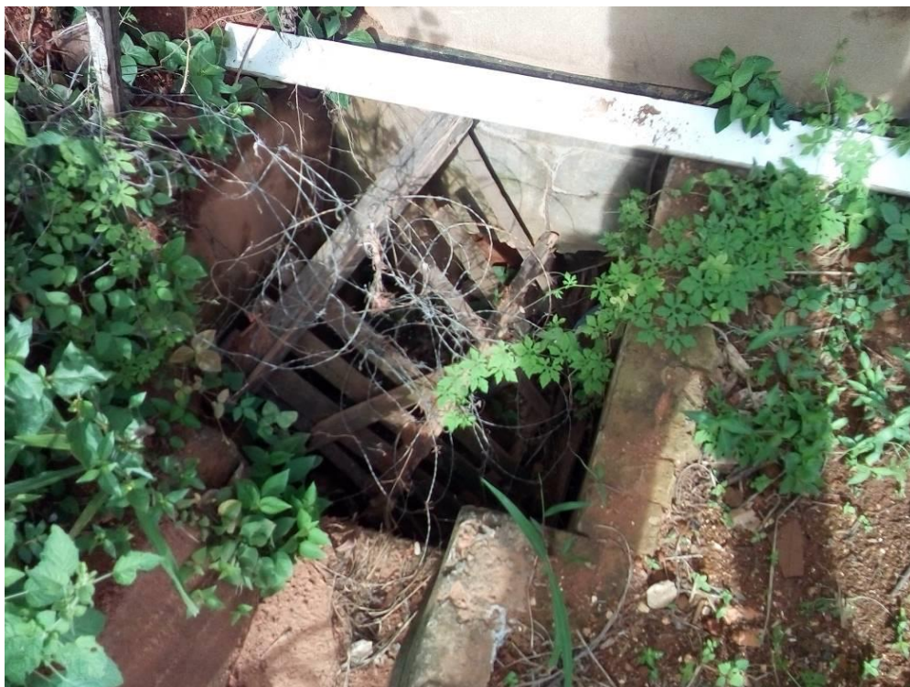
Figura 4.6 – Drenagem pluvial existente no pé do talude, necessária ação de limpeza e recuperação
