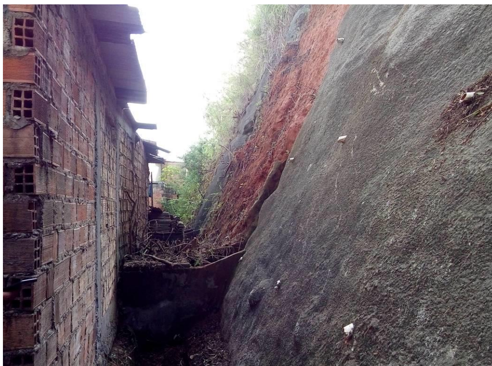
Figura 4.1 – Talude parcialmente protegido
