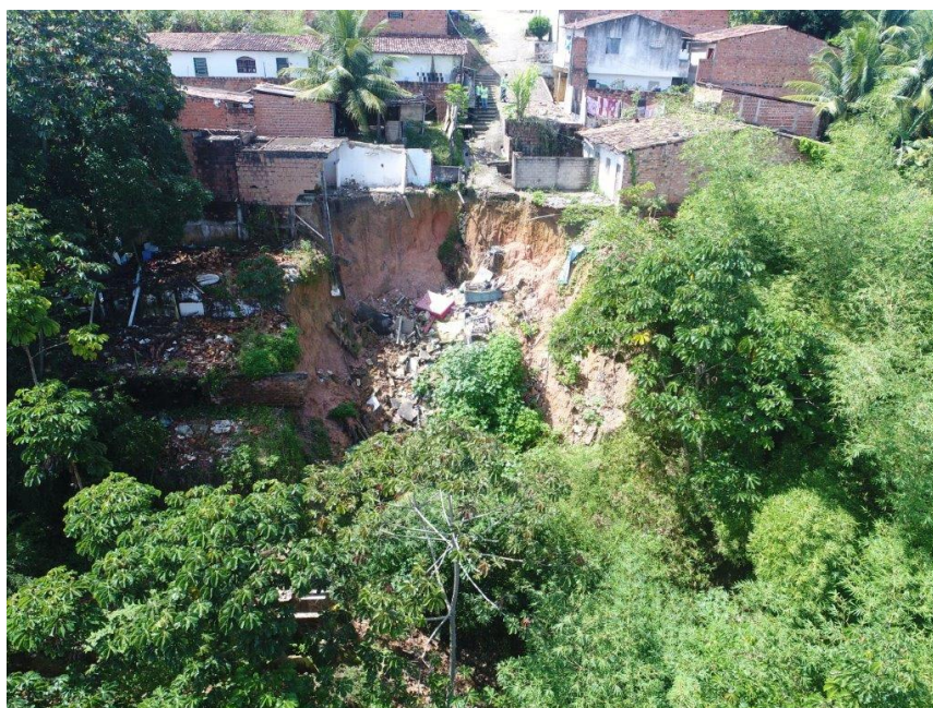
Figura 2 - Casas em situação de risco na encosta Princesa Diana.
