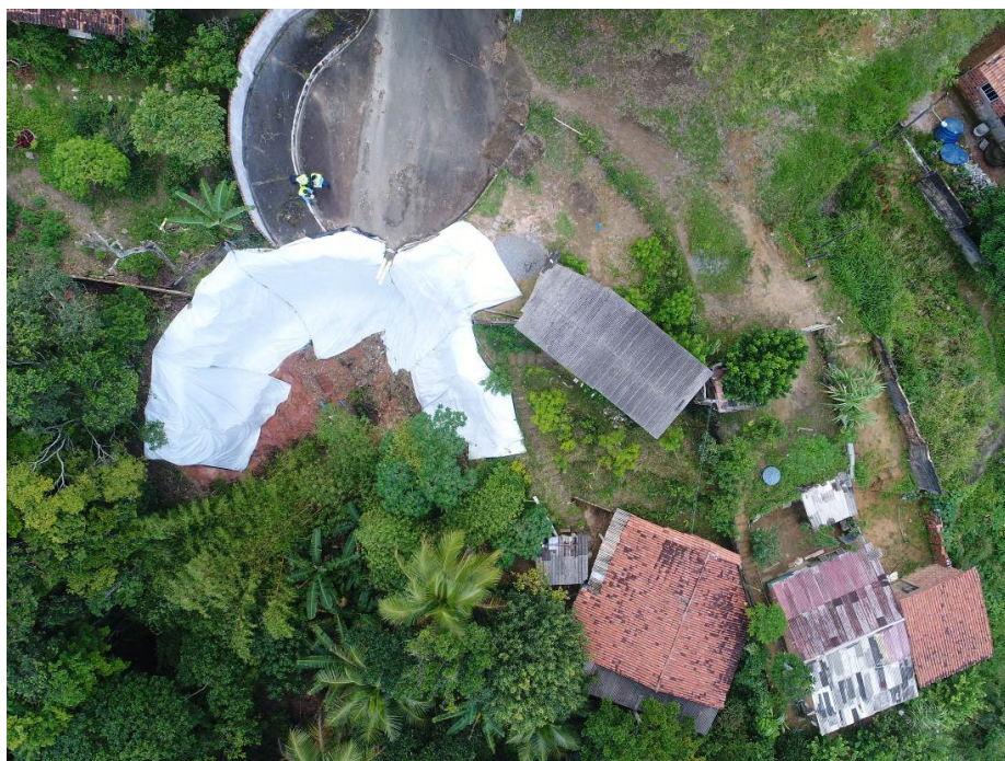
Figura 3 - Casas em situação de risco na encosta Jardim Petrópolis.
