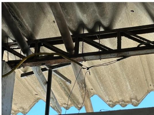
Figura 2 – Treliça metálica enferrujada, danificada e com fiação elétrica exposta às intempéries.
