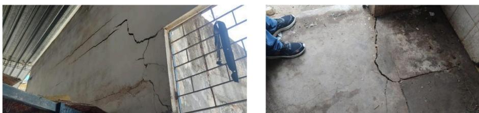
Figura 1 - Situação atual do piso e paredes, trincas e infiltrações
