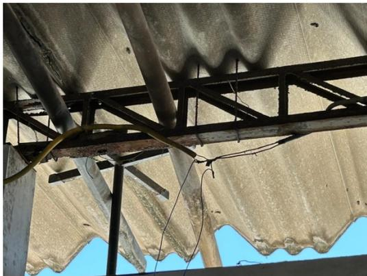
Figura 2 – Treliça metálica enferrujada, danificada e com fiação elétrica exposta as intempéries.
