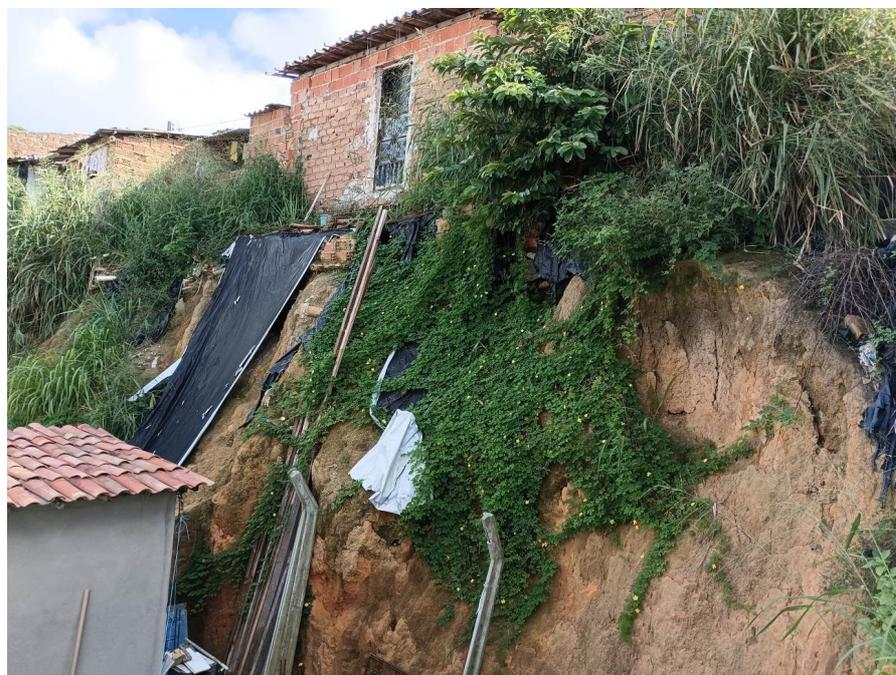
*Figura 3 – Situação do talude, observa-se a implantação das edificações na crista e cicatrizes de escorregamento com formação de taludes negativos.*
