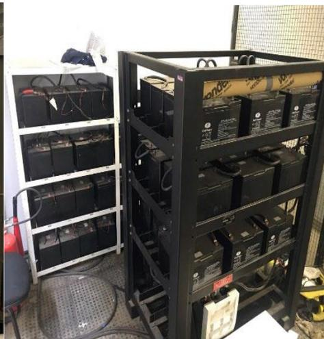
Figura 4 - Banco de baterias na subestação
