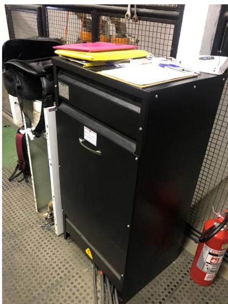
Figura 1 - Transformador UPS 1
