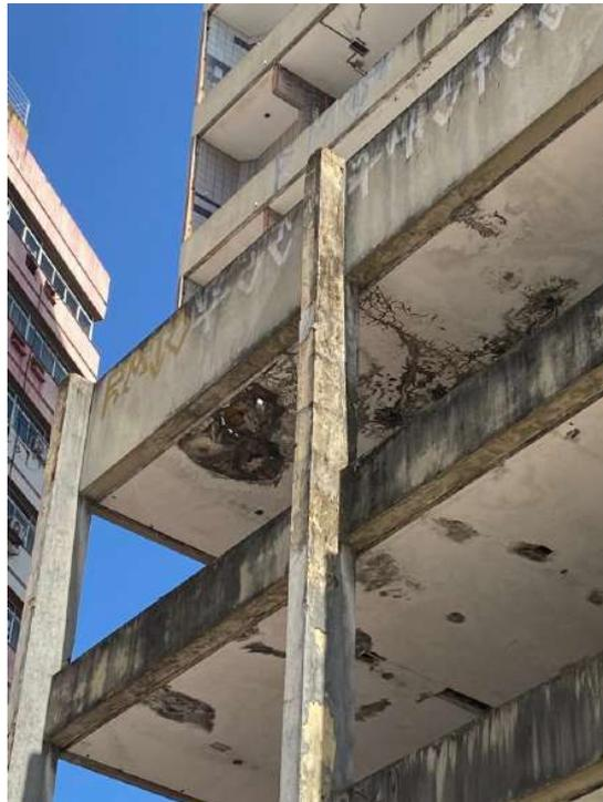
Foto 02 – Pontos de deterioração na laje com armadura a mostra entre outras patologias nos pilares e vigas.
