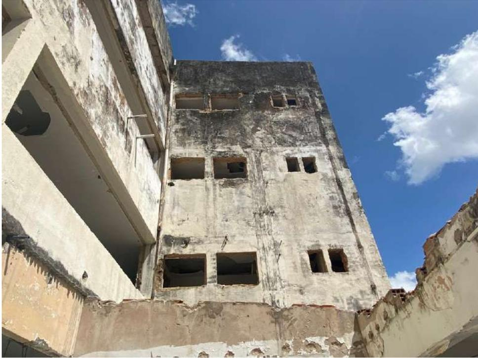
Foto 03 – Danos causados na estrutura, com falta de esquadrias, pintura, dentre outras patologias.
