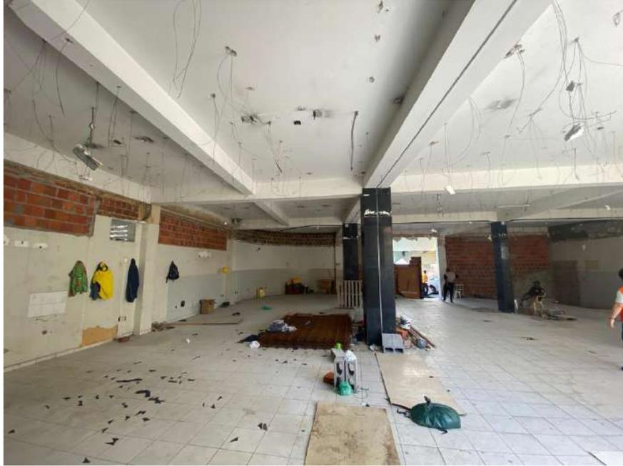
Foto 07 – Danos causados na estrutura, com falta de esquadrias, pintura, coberta, revestimento, dentre outras patologias.
