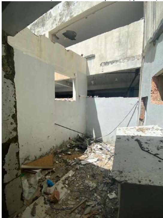
Foto 04 – Danos causados na estrutura, com falta de esquadrias, pintura, cobertura, revestimento, dentre outras patologias.
