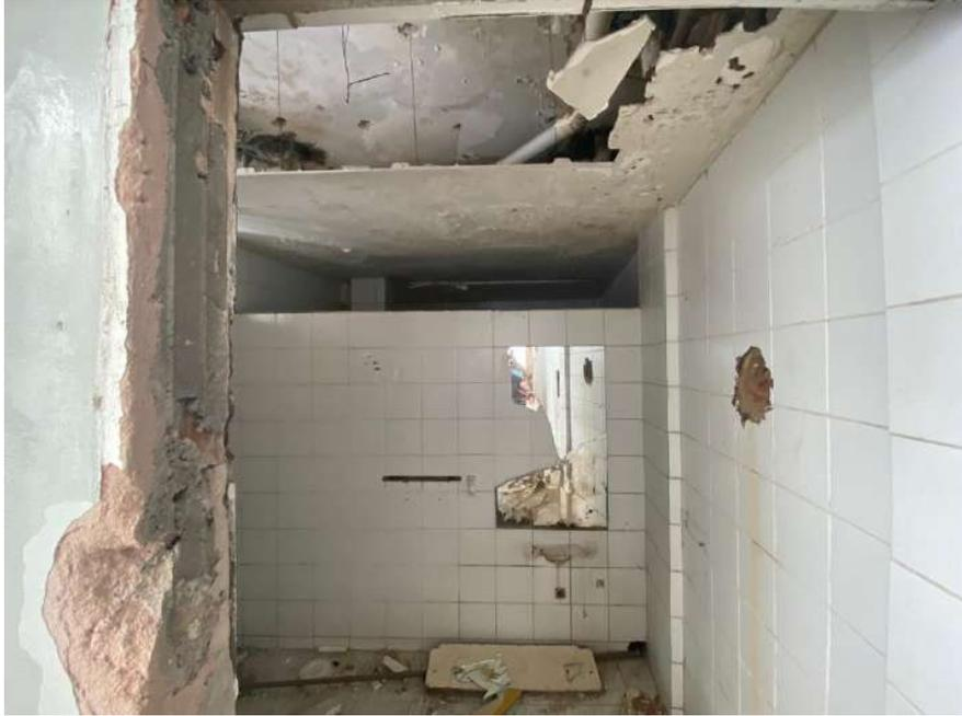
Foto 05 – Danos causados na estrutura, com falta de esquadrias, pintura, coberta, revestimento, dentre outras patologias.
