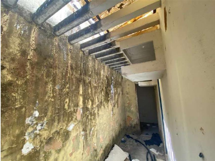
Foto 06 - Danos causados na estrutura, com falta de esquadrias, pintura, coberta, revestimento, dentre outras patologias.
