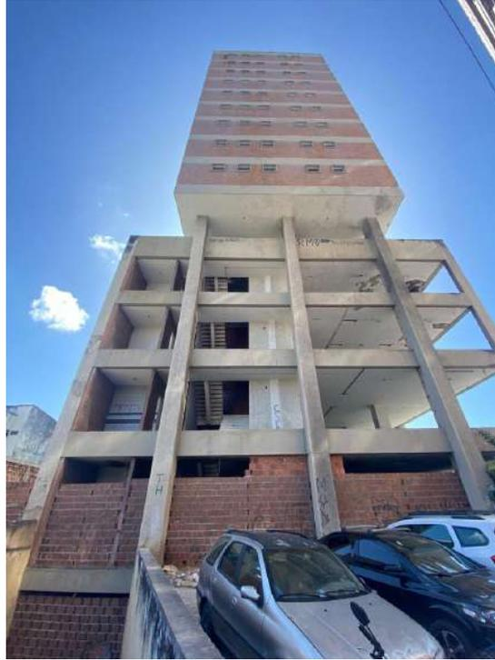
Foto 05 – Fachada lateral com parte vedada em alvenaria em alguns andares.
