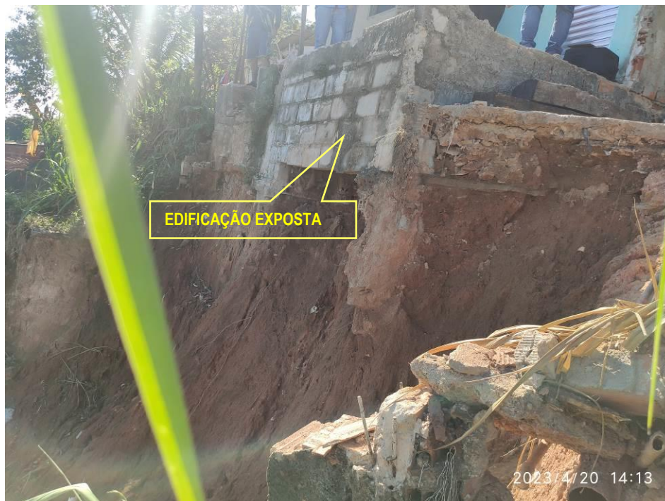
Figura 5.11.- Ponto 03 - Vista lateral da figura anterior, percebe-se a formação de taludes verticais e negativos, é importante salientar que o maciço afetado é conformado por aterro lançado.
