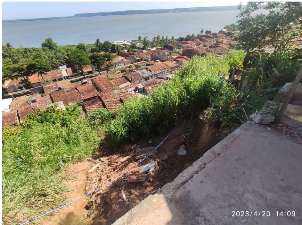
Figura 5.13.- Imagem superior do talude do ponto 03, observa-se o material escorregado proveniente da ruptura, a presença de vegetação densa e de edificações no pé do talude.
