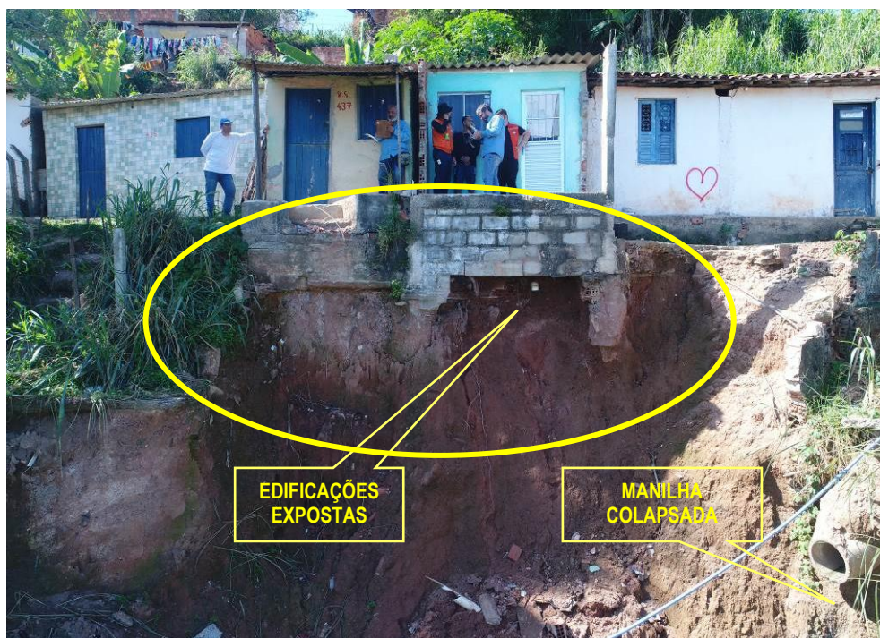
Figura 5.10.- Ponto 03 – Detalhe da situação mostrada na figura anterior, observa-se que parte das edificações se encontram “voando”, à direita, manilha de concreto cujo colapso, certamente foi o gatilho para deflagrar o escorregamento ocorrido.
