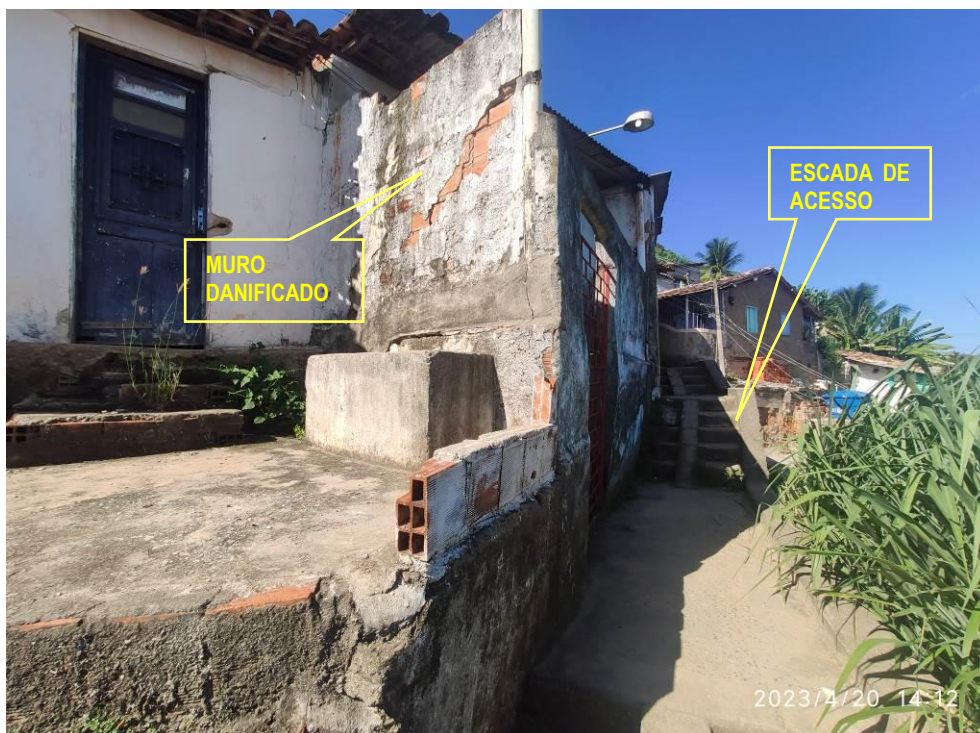
Figura 5.14.- Ponto 03 - Escadaria que liga a crista do talude a Rua Dr. Oswaldo Cruz, sob esta escadaria desce a manilha mostrada na Figura 5.10, que conduz as águas coletadas nas ruas a montante até o talude.
