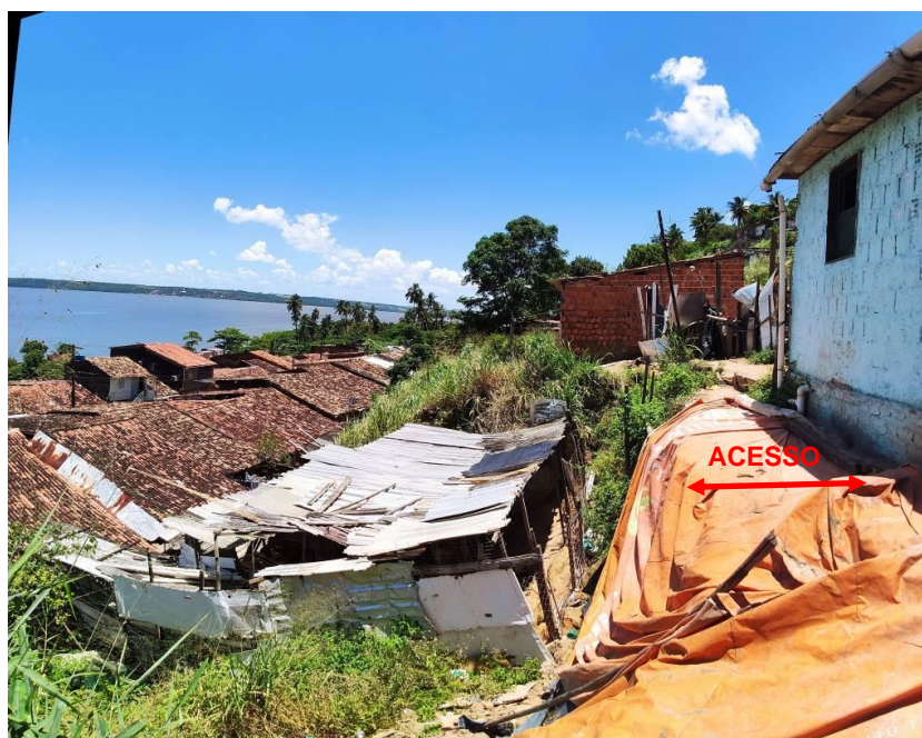
Figura 5.8.- Ponto 01/02 - Vista de um trecho da encosta onde os escorregamentos ocorridos atingiram o acesso utilizado pelos moradores, diminuindo a sua largura elevando o risco de acidentes.
