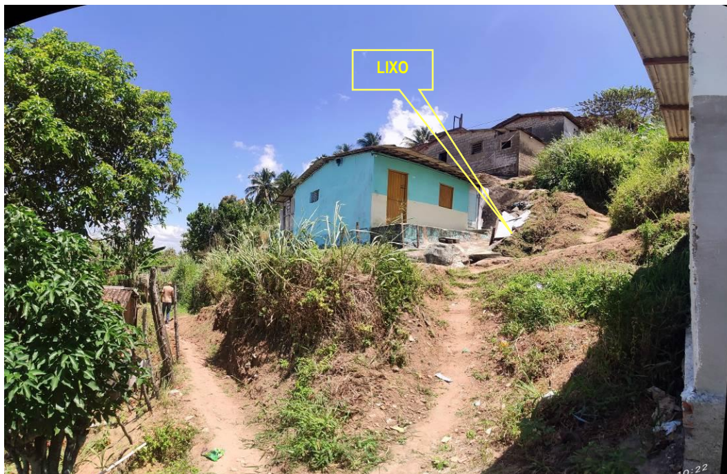
Figura 5.4.- Ponto 01/02 -Observa-se a presença de lixo e entulho no talude, além de edificações desordenadas a meia encosta/crista e taludes sub verticais devido a escavações de moradores.
