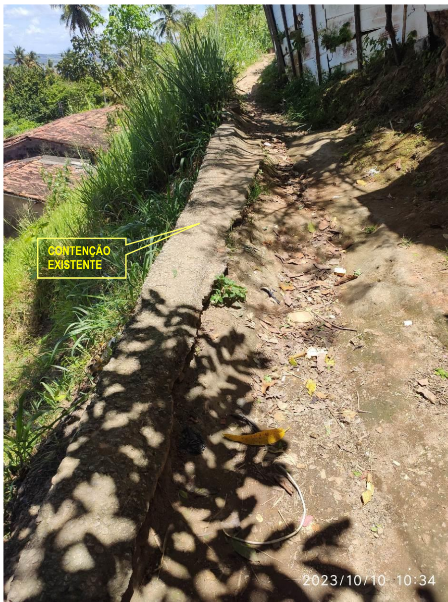
Figura 5.6.- Ponto 01/02 - Imagem tirada na lateral direita da Figura 5.5 , observa-se uma contenção existente em alvenaria de pedra na lateral da escada de acesso.
