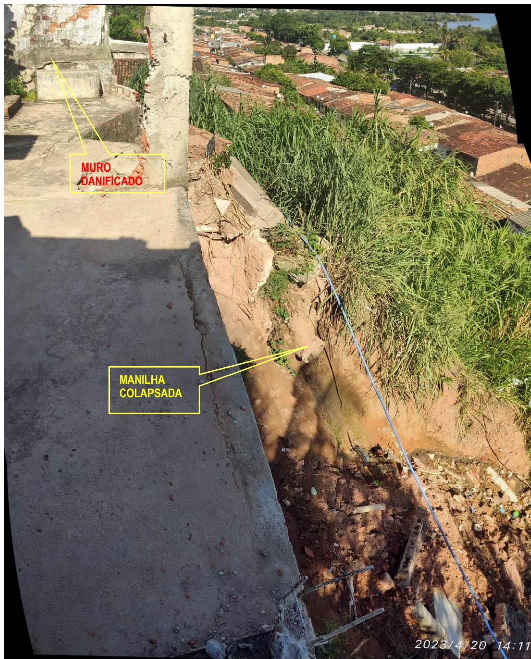
Figura 5.15.- Ponto 03 - Vista da lateral do talude, observa-se uma manilha que coleta águas a montante e deságua na face do talude, localizada abaixo da escadaria que dá acesso a crista do talude, a mesma encontra-se colapsada.
