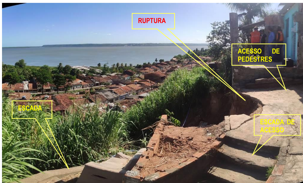
Figura 5.12.- Ponto 03 - Foto lateral superior do talude, observa-se parte do passeio/ acesso aos pedestres danificado pela ruptura.
