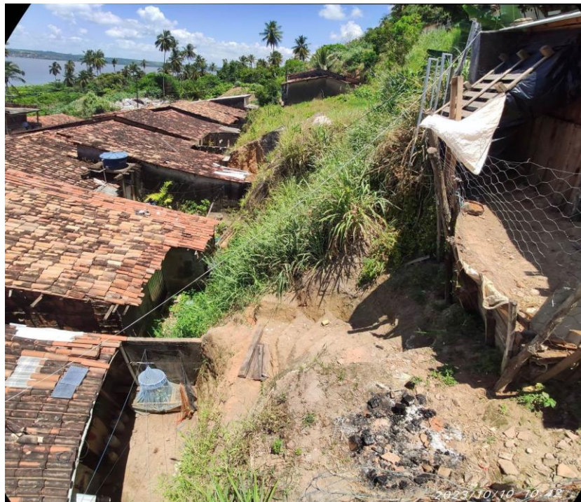
Figura 5.7.- Ponto 01/02 - Vista lateral do talude onde pode-se observar o desnível entre as edificações a jusante e a meia encosta, além da inclinação acentuada em alguns pontos do talude.
