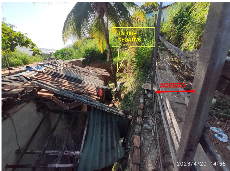
Figura 5.11.-Vista dos fundos das edificações localizadas na porção média da encosta, observar que os muros dos quintais fazem o papel de contenção.
