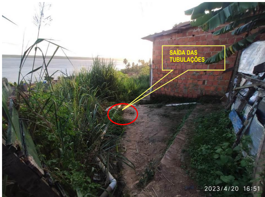
Figura 5.18.-Vista de outro acesso, observar o entroncamento de tubulações que despejam seus deflúvios desordenados e concentrados na face do talude.
