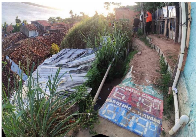
Figura 5.17.-Trecho de um acesso localizado na crista do talude, prejudicado pela ocorrência de escorregamentos, verifica-se a existência de grande número de tubulações que atravessam a encosta.
