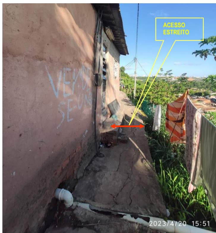
Figura 5.12.-Porção superior do talude, observar o péssimo estado de conservação do acesso de pedestres que em diversos trechos tem a sua largura diminuída, colocando em risco a integridade dos pedestres.
