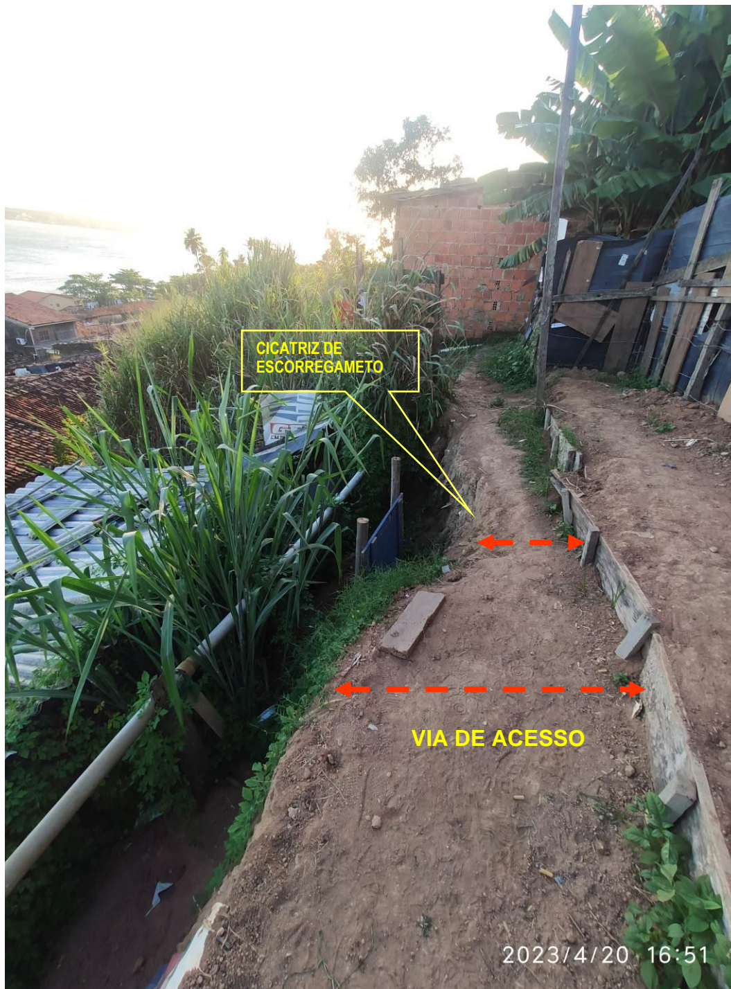
Figura 5.19.-Detalhe da Figura 5.17, pode ser observada uma tubulação percorrendo paralelamente a face do talude além, verifica-se também a diminuição da largura do acesso devido a escorregamentos ocorridos.
