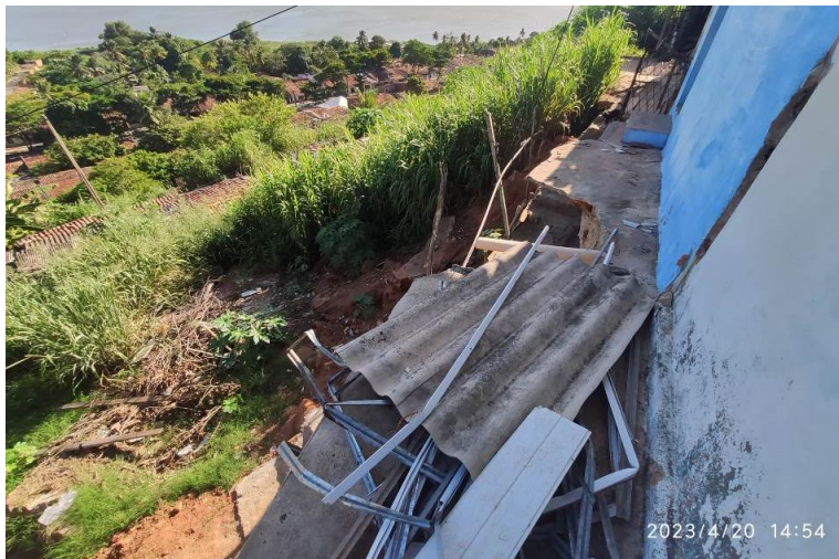
Figura 5.9.-Vista superior da foto anterior, nota-se a via de acesso dos moradores danificada devido ao escorregamento que ocorreu no local.
