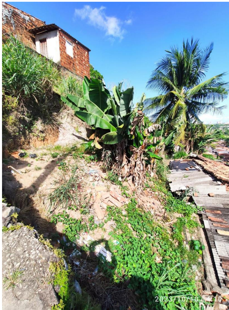
Figura 5.2. Vista da meia encosta, observa-se grande quantidade de lixo e entulho depositado na superfície do talude, além da presença de bananeiras e edificações implantadas na linha de crista e pé da encosta.
