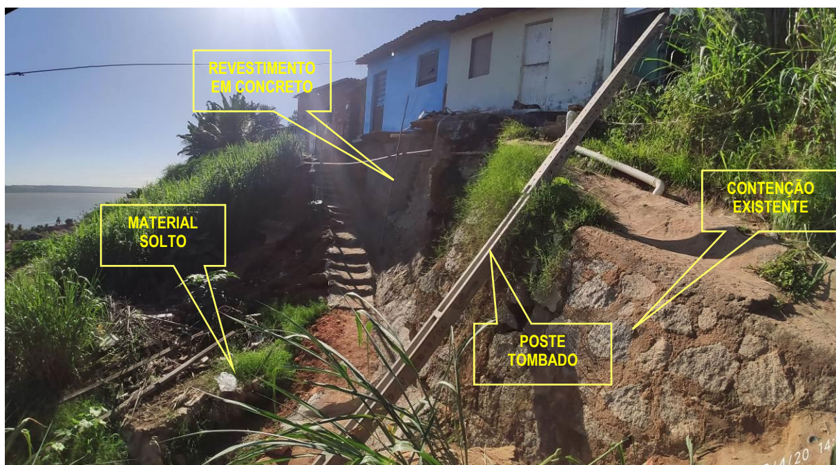
Figura 5.8.-Região de ocorrência do escorregamento do ponto de risco 04, o acesso às edificações localizadas na crista colapsou, pode se observar a formação de taludes negativos sob as edificações, este é um dos locais com espessa camada de aterro.
