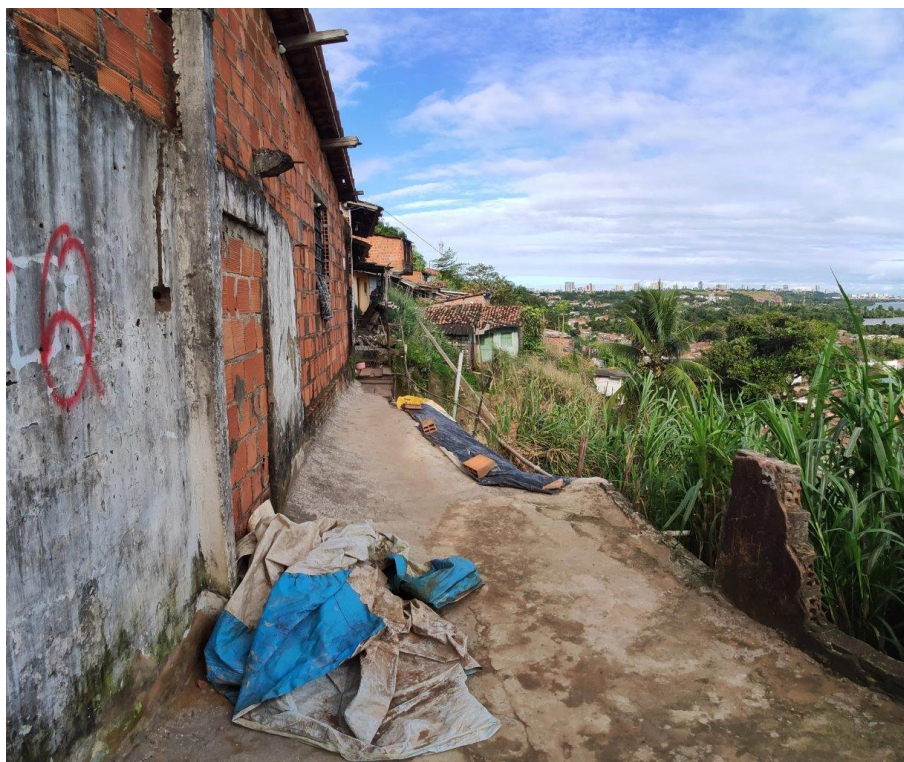
Figura 5.14.- Outro trecho de acesso interrompido pela ocorrência de escorregamentos, toda a região de crista da encosta é constituída por material lançado sem qualquer tratamento que aumente a sua resistência.
