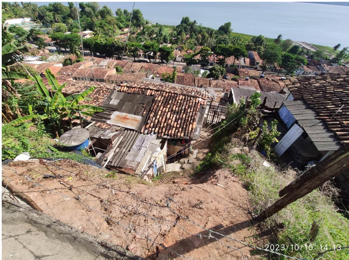
Figura 5.5.-Vista superior de uma parte da encosta, possível identificar um talude negativo proveniente de escavações feitas por moradores na tentativa de adquirir espaço para edificações. Além do desnível entre a crista do talude e as edificações a jusante.
