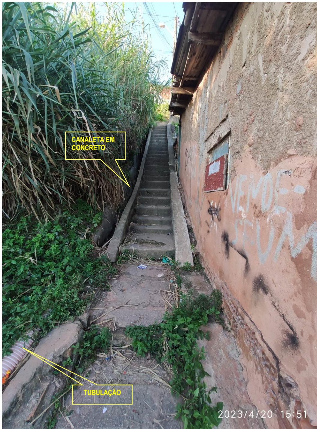
Figura 5.15.-Escadaria que liga o final do ponto de risco 06 com a rua Oswaldo Cruz, observa-se uma tubulação exposta, este tipo de tubulação pode ser observado ao longo de toda encosta, não sendo possível identificar a destinação final dos deflúvios transportados.
