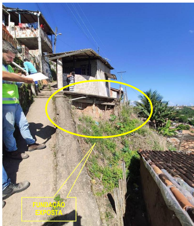
Figura 5.3.-Vista de um trecho da encosta, observa-se a exposição da fundação da edificação implantada na crista do talude.
