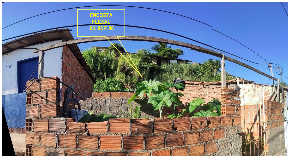
Figura 5.7.-Vista da parte superior da encosta, mais uma vez verifica-se a presença de edificações implantadas na linha de crista do talude.
