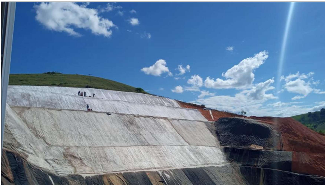
Figura 22 – Vista frontal do talude durante a execução de chapisco de argamassa, local da CAT n° 2793709/2021.
