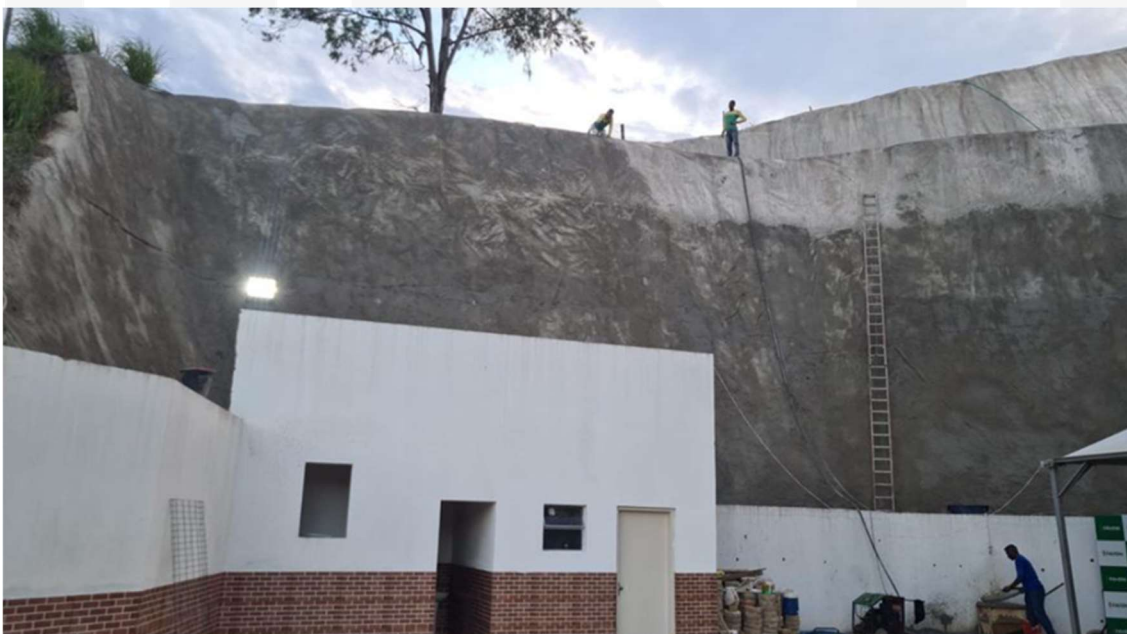
Figura 23 – Vista do talude da CAT n° 2843479/2021 recebendo a segunda demão de chapisco de argamassa, com a utilização de bomba jateadora.
