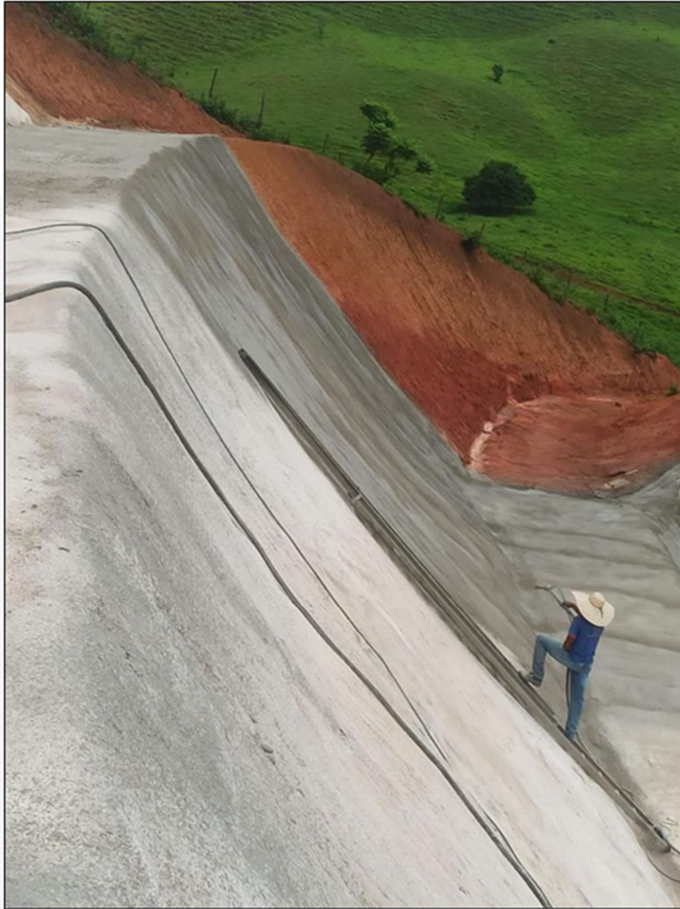
Figura 28-A – Vista dos taludes com recebendo a segunda demão de chapisco de argamassa, área da CAT nº 2793709/2021.
