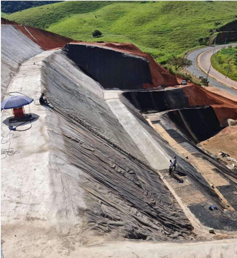
Figura 27-A – Registros fotográficos da bomba jateadora de argamassa, sendo utilizada nos taludes da Rede FAVENI.
