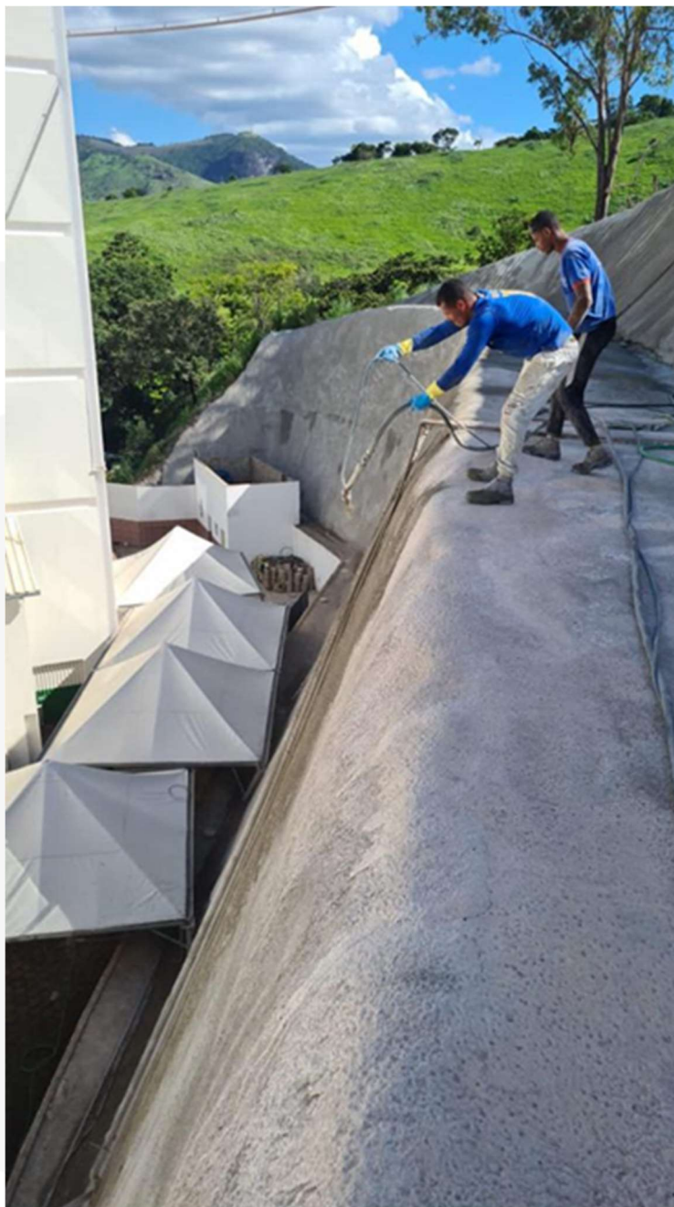
Figura 24 – Vista do talude da CAT n° 2843479/2021 recebendo a segunda demão de chapisco de argamassa, com a utilização de bomba jateadora.
