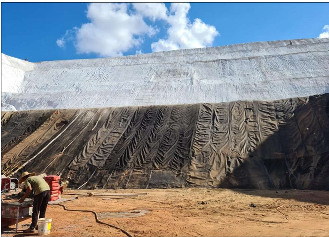
Figura 25 – Vista frontal da área do talude da CAT n° 2793709/2021.
