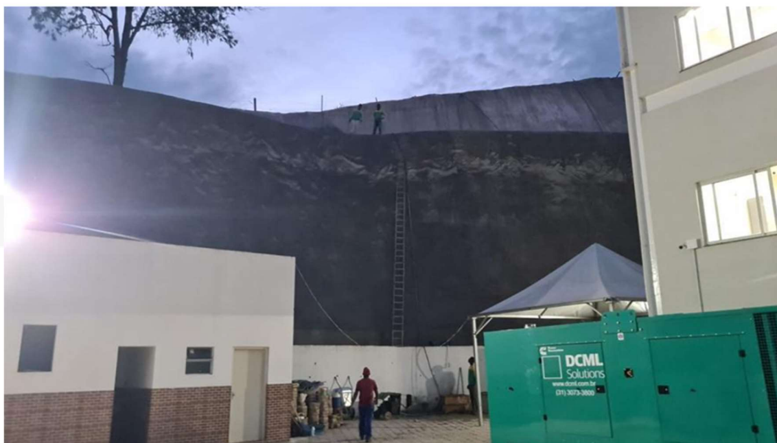
Figura 29 – Vista do talude referente a CAT n° 2843479/2021, após segunda demão de chapisco de argamassa.
