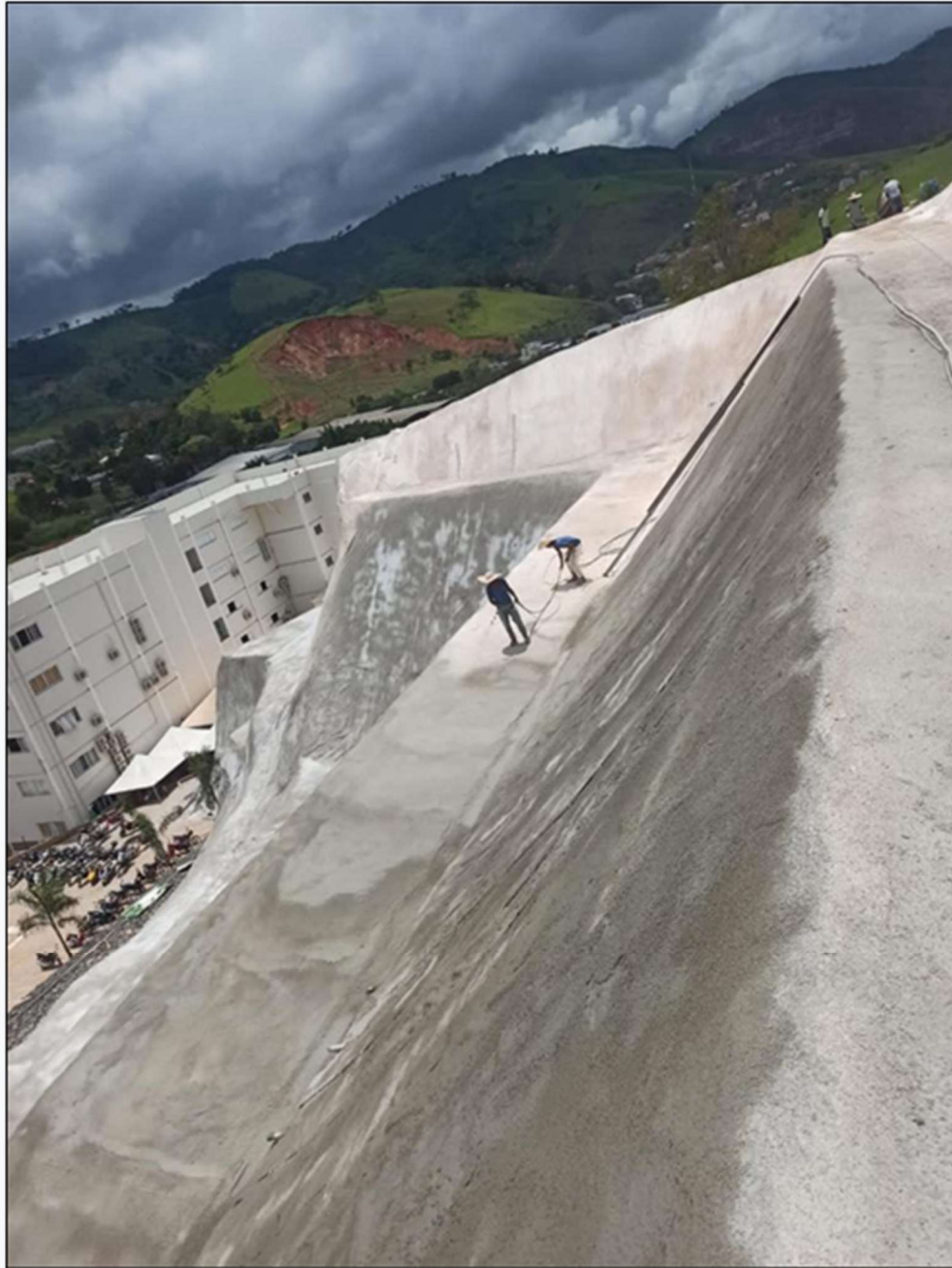
Figura 28 – Vista dos taludes com recebendo a segunda demão de chapisco de argamassa, área da CAT nº 2793709/2021.
