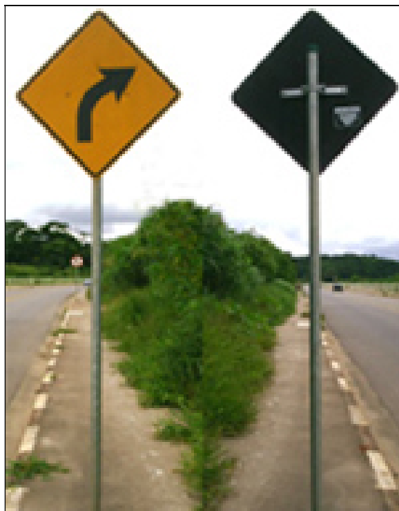
FIGURA 13 - PLACA DE SINALIZAÇÃO COM FIXAÇÃO POR COLUNA PP, EM TUBO DE AÇO GALVANIZADO
