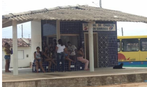
TERMINAL DE ÔNIBUS CIDADE SORRISO 2
