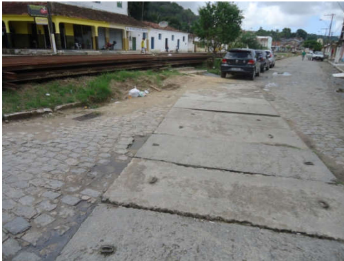
Figura 18: Encontro da tubulação de drenagem com o trilho do trem. Fonte: SEMPLA, 2013.
