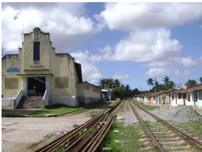
Imagem 18 - Material de construção, e trilhos as margens da linha férrea avançando na rua. Nesta sentido o transporte ferroviário segue pela estação, de Rio Largo até a estação de Maceió.
