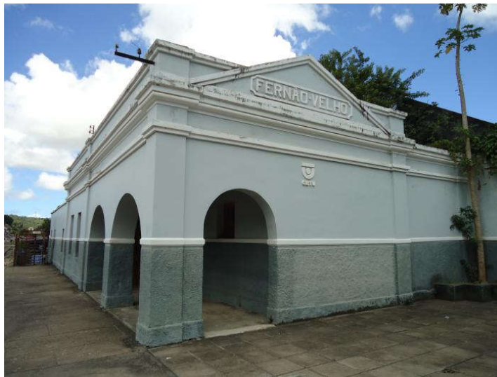
Figura 5: Estação Ferroviária de Fernão Velho. Fonte: Wikimapia, 2007.
