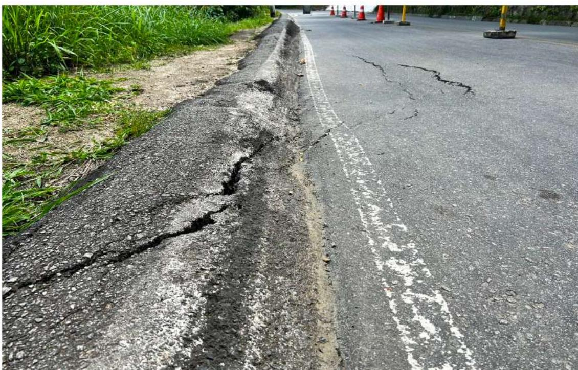
*Figura 3 – Situação do pavimento com a presença de afundamento e trincas.*
